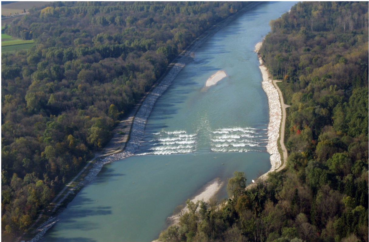
Figure 15: Step-pool-ramp with a boat lane (Amt der Oberösterreichischen Landesregierung 2011)
