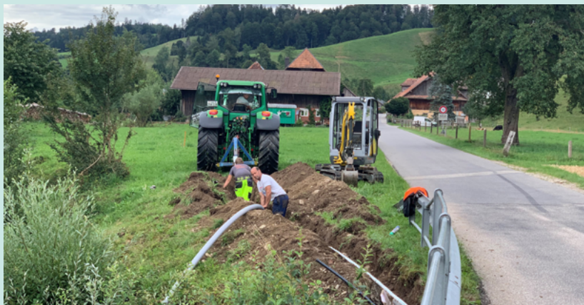
Figure 8 - Le réseau local en fibre optique de Luthern est en cours d'installation (RLW)
